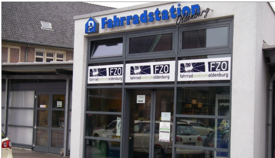
Abb. C-11: Die Fahrradstationen am Hauptbahnhof von Oldenburg bieten neben der Aufbewahrung auch Reparaturservice sowie Vermietung und Verkauf von Fahrrädern an. (Foto ZVBN)
