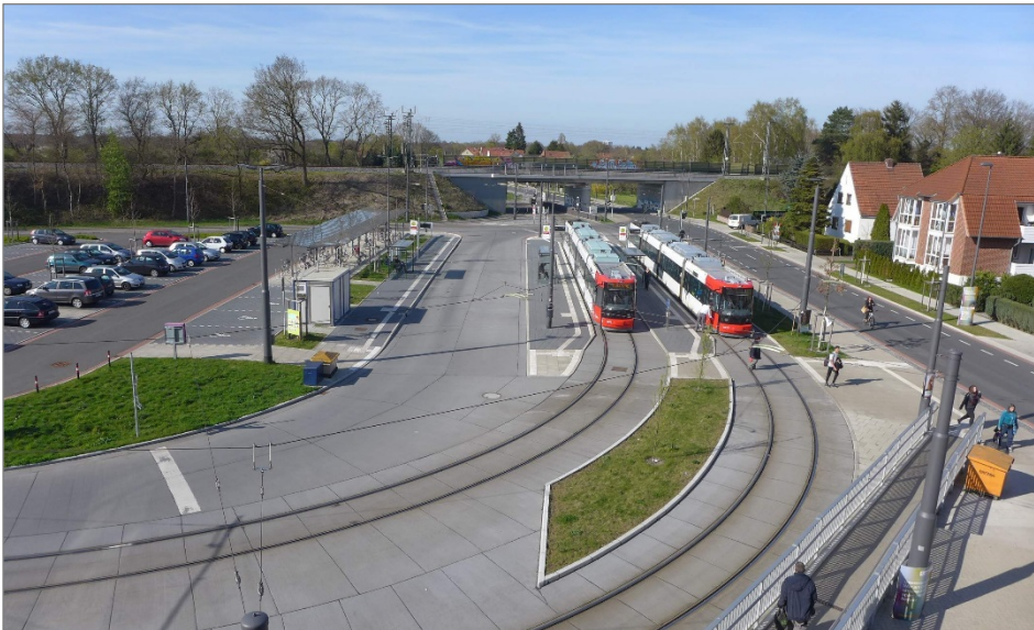
Abb. C-9: In Bremen-Mahndorf wurden auf beiden Seiten der Bahnstrecke Verknüpfungen vom SPNV zum übrigen ÖPNV mit kurzen Fußwegen und ohne Straßenquerung zwischen den Bahnsteigen und den Haltestellen hergestellt. (Foto ZVBN)
