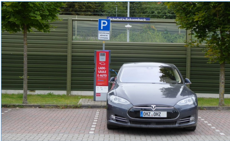
Abb. C- 14: Die Ladesäule am Bahnhof Osterholz-Scharmbeck wird zwar regelmäßig genutzt, aber nicht von Bahnpendelnden. (Foto ZVBN)
