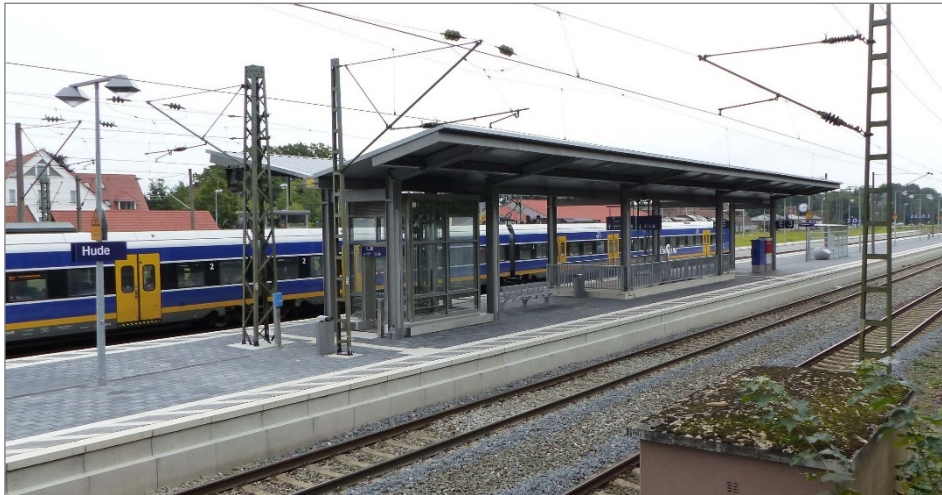
Abb. C-6: Am Bahnhof Hude gibt es auf dem Mittelbahnsteig im Bereich des Treppenaufgangs und des Aufzugs ein Bahnsteigdach. Ergänzt wird der Wetterschutz auf diesem Bahnsteig durch zwei Fahrgastunterstände mit Sitzgelegenheiten.
