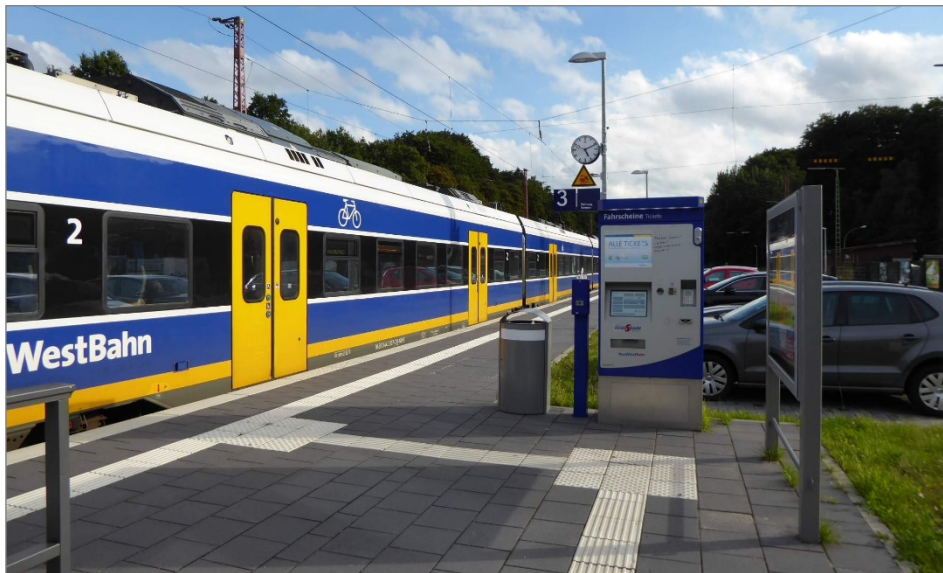
Abb. C-13: Am Bahnhof Oldenbüttel wurden durch die Gemeinde Hambergen direkt neben dem neuen Außenbahnsteig P+R-Stellplätze angelegt. (Foto ZVBN)
