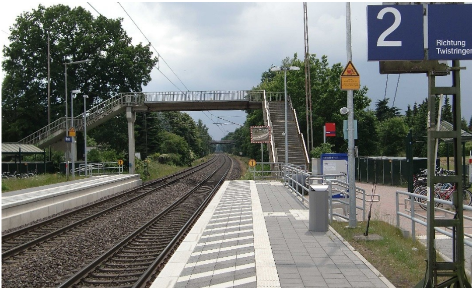
Abb. A-8: In Barrien wurden zwar die Bahnsteige erneuert und erhöht. Die Verbindung beider Bahnsteige führt jedoch auch weiterhin nur über die Treppen der bestehenden Fußgängerbrücke. Damit ist eine stufenlose Zugänglichkeit nicht durchgängig gegeben. (Quelle: ZVBN)
