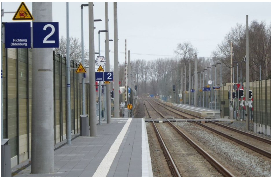
Abb. A-5: An der Bahnstrecke Oldenburg – Wilhelmshaven ist im Sommer 2020 der neue Bahnhaltepunkt Jaderberg eröffnet worden. (Quelle: ZVBN)
