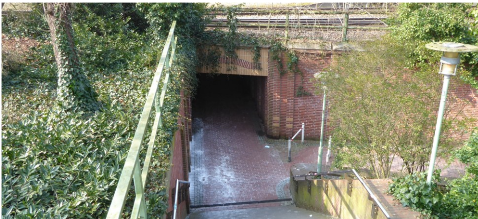
Abb. A-10: Die Zugangsbereiche zum südlichen Bahnhofstunnel in Verden (Al-ler) vermitteln einen etwas vernachlässigten Eindruck. (Quelle: ZVBN)
