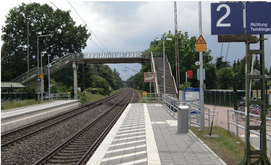
Abb. A-8: In Barrien wurden zwar die Bahnsteige erneuert und erhöht. Die Verbindung beider Bahnsteige führt jedoch auch weiterhin nur über die Treppen der bestehenden Fußgängerbrücke. Damit ist eine stufenlose Zugänglichkeit nicht durchgängig gegeben. (Quelle: ZVBN)
