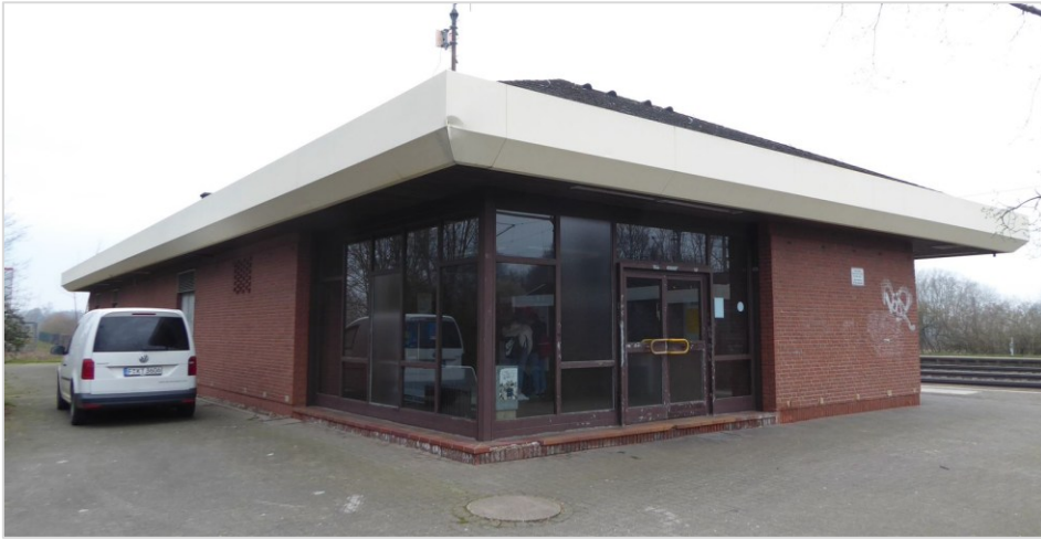
Abb. A-11: Der Flecken Lemförde hat das Bahnhofsgebäude erworben. Damit kann sichergestellt werden, dass der Warteraum auch nach der anstehenden Modernisierung der Verkehrsstation noch zur Verfügung steht. (Quelle: ZVBN)
