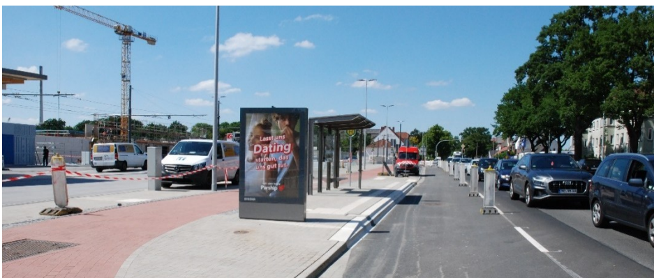
Abb. A-2 Bushaltestelle mit Kasseler Sonderbord und einer Bordhöhe mit 22 cm Bremen Gröpelingen (Quelle: ZVBN)
