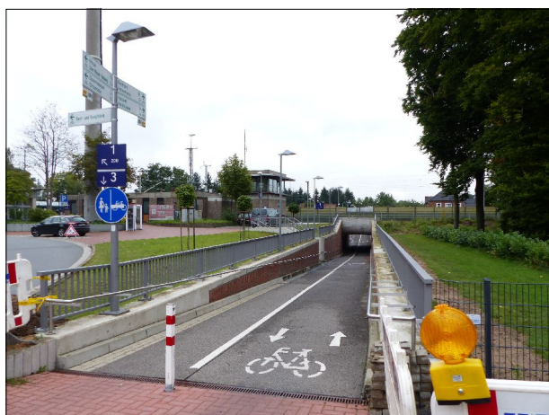
Abb. 42: Der Bahnhof Eystrup wurde grundlegend umgebaut. Der Bahnsteig in Richtung Bremen ist mittels Unterführung mit Rampen und Treppen zu erreichen. Zugleich stellt die Unterführung eine wichtige Ortsteilverbindung für Fußgänger und Radfahrer dar.
