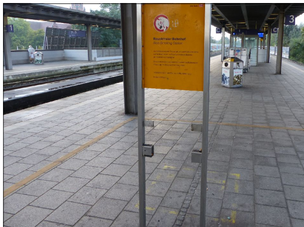
Abb. 20: In Delmenhorst gibt es zwar einen Raucherbereich auf dem Mittelbahnsteig, der dafür notwendige Ascher fehlte jedoch.
