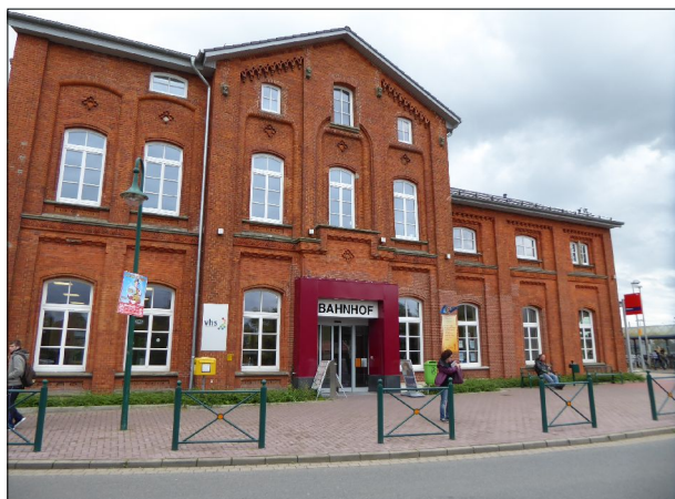
Abb. 35: In Bassum wurde das Bahnhofsgebäude durch die Stadt umfassend saniert. Dabei konnten ein Reisebüro mit Fahrkartenverkauf, ein Kiosk/Bäcker, öffentliche Toiletten sowie im Obergeschoss die VHS integriert werden.
