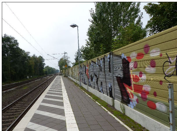
Abb. 53: In jüngster Zeit wurden zahlreiche Bahnstrecken und Stationen mit Lärmschutzwänden ausgerüstet. Der Wartekomfort für Fahrgäste sowie das Erscheinungsbild der Stationen leiden jedoch darunter (im Foto: Sottrum).
