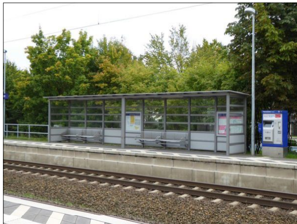
Abb. 55: In den neuen Unterständen, wie hier in Etelsen, sind in der Regel große Infovitrienen (DIN A0-Format) integriert. Diese bieten genügend Platz für Aushänge und sind zudem witterungsgeschützt und beleuchtet.
