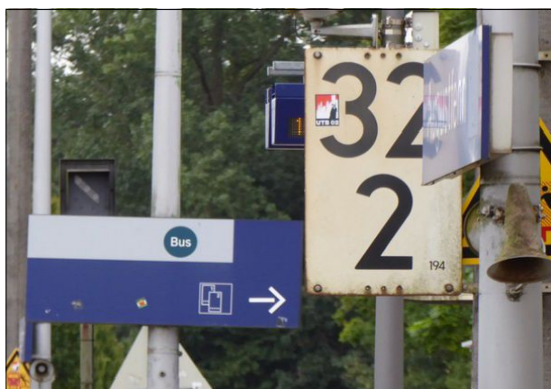
Abb. 24: Der DSA an Gleis 1 in Augustfehn ist einseitig durch eine Kilometertafel verdeckt.
