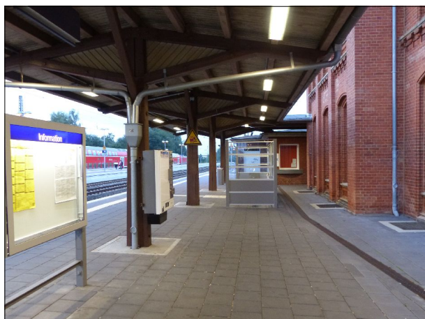
Abbildung 14: Der Erhalt des Bahnsteigdaches neben dem Empfangsgebäude in Syke bietet den Fahrgästen einen umfassenden Schutz vor Niederschlägen und Sonnenstrahlung.
