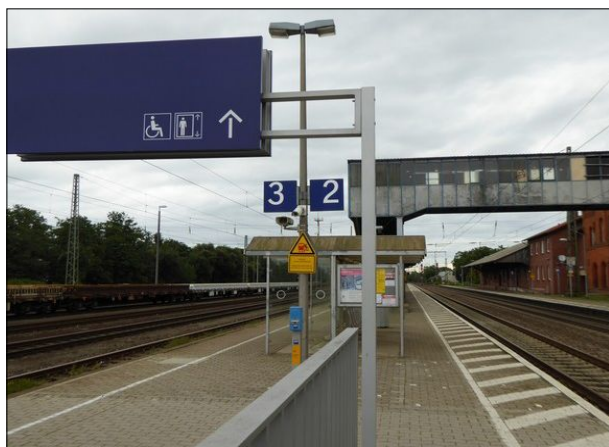
Abb. 30: Die Wegeleitung auf dem Mittelbahnsteig in Diepholz weist einseitig zum Aufzug in die falsche Richtung.
