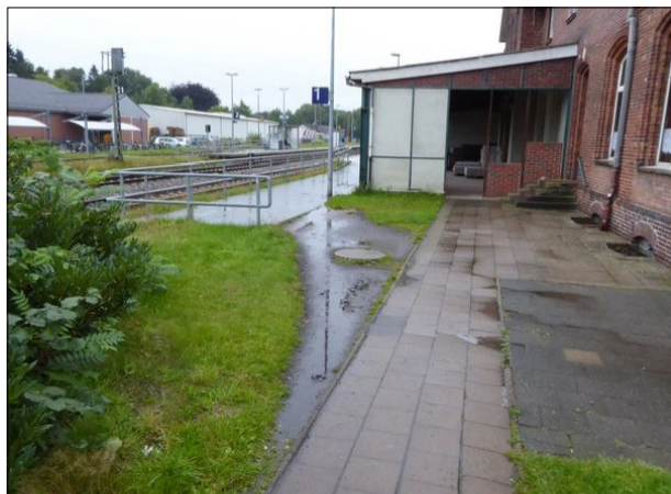
Abb. 40: Unbefriedigend ist die fehlende Pflasterung eines kleinen Abschnitts im Zugang zu Gleis 1 vom Bahnübergang in Ahlhorn.
