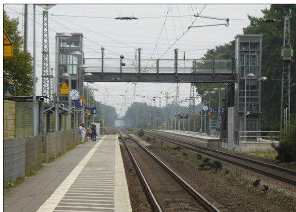
Abb. 4: Auch die Station Sottrum wurde durch die Erhöhung der Bahnsteige sowie den Einbau von Aufzügen auf beiden Bahnsteigen konsequent stufenfrei ausgebaut.
