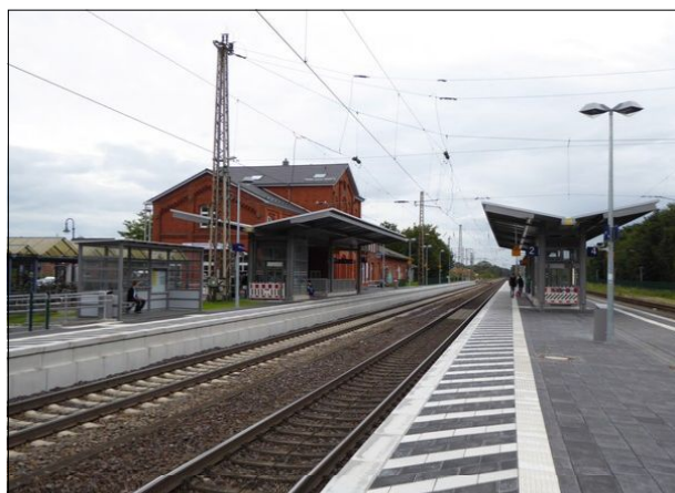
Abb. 2: Die Erneuerung der Bahnsteige und des Tunnels in Bassum haben den Bahnhof stark aufgewertet. Die Aufzüge waren jedoch noch nicht in Betrieb.
