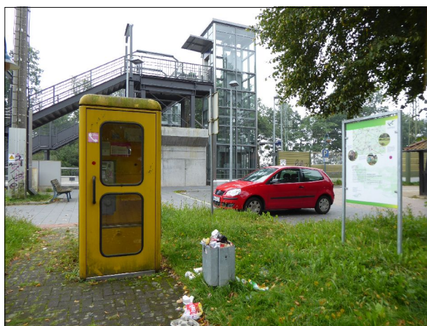
Abb. 21: Nicht nur auf den Bahnsteigen, sondern auch auf den Bahnhofsvorplätzen (hier: Sottrum) beeinträchtigen überfüllte Abfallbehälter das Erscheinungsbild.
