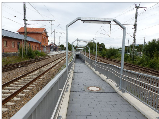
Abb. 5: Der Bahnhof Barnstorf konnte durch den Einbau eines Aufzugs am Hausbahnsteig sowie einer Rampe am Mittelbahnsteig barrierefrei ausgebaut werden.
