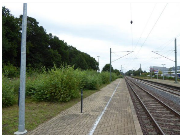
Abb. 48: Im Bereich der Verlängerung des Bahnsteigs an Gleis 2 in Westerstede-Ocholt gibt es keine Beleuchtung.
