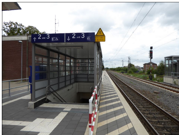
Abb. 8: Beengter Bereich am Hausbahnsteig von Twistringen, der die Fahrgäste aufgrund von Schnellfahrten dazu zwingt, auf andere Bereiche auszuweichen.
