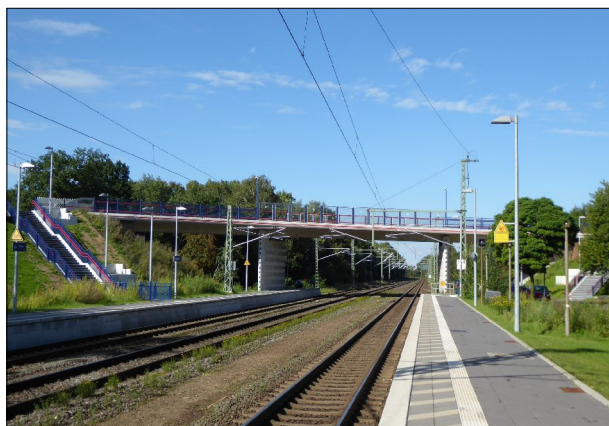
Abb. 6: Der Bahnhof Stubben wurde durch Erhöhung der Bahnsteige mit Anbindung an den BÜ barrierefrei ausgebaut. Mit der Schließung des BÜ und Wegführung über die Straßenbrücke entsteht jedoch eine neue Situation. Durch Errichtung von beidseitigen Rampenbauwerken kann die Barrierefreiheit wieder hergestellt werden.
