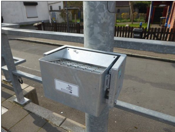
Abbildung 14: In Bremen Mühlenstraße wurde der Aschenbecher erneuert.
