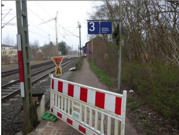
Abbildung 46: Durch die Sperrung des regulären Zugangs zu Gleis 3 in Bremen-Oberneuland ist der dort platzierte DSA vom Bahnsteig aus nur schwer zu erkennen.
