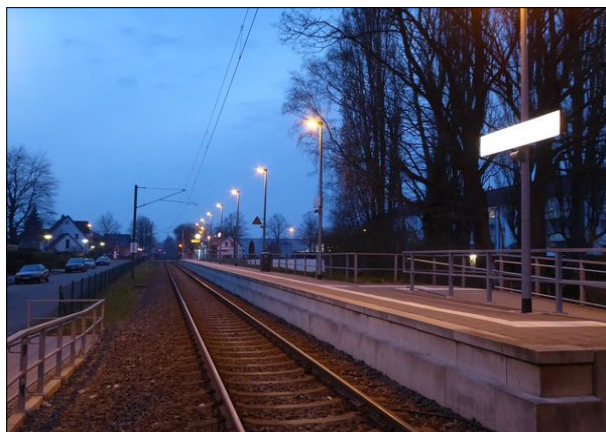
Abbildung 39: Sowohl die Bahnsteig- und Zugangsbeleuchtung als auch die Beleuchtungen der Vitrinen und Schilder funktionierten in Bremen Kreinsloger einwandfrei.
