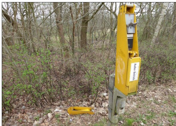
Abbildung 42: Die außer Betrieb gesetzten Sprechstellen an den Bahnsteigen in Bremen-Oberneuland wurden beschädigt.
