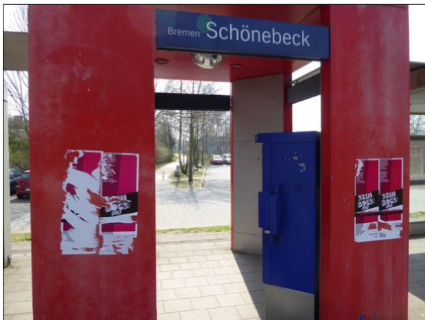
Abbildung 11: Durch verblasste Farbe und großflächige Beklebung beeinträchtigt der Wettergeschütz in Bremen-Schönebeck an Gleis 1 das Erscheinungsbild.
