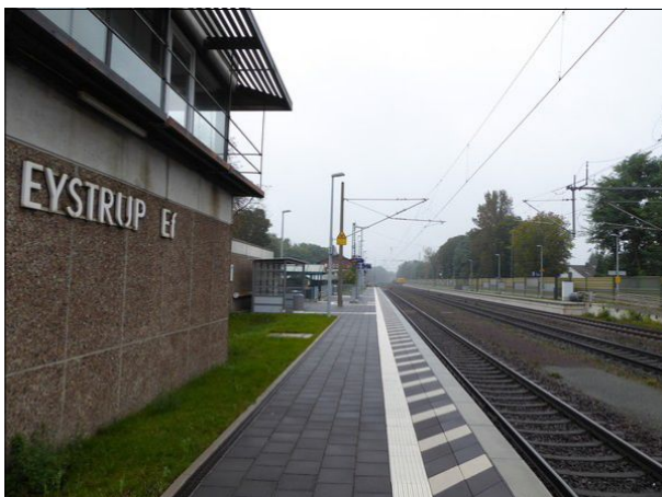
Abb. 3: Mit der Erneuerung des Hausbahnsteigs wurde die Modernisierung der Verkehrsstation Eystrup abgeschlossen.
