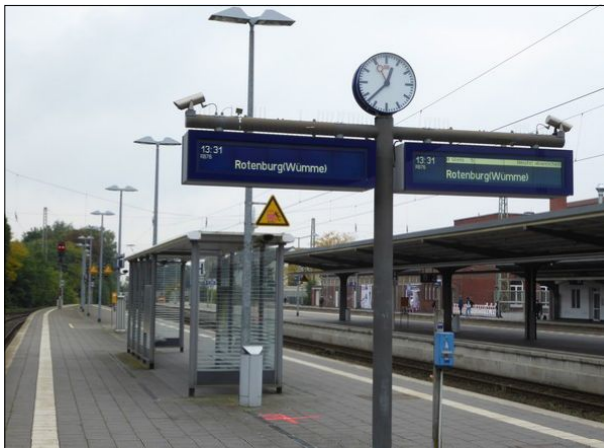
Abb. 29: Trotz des Wegfalls der Anzeige der Gleisnummern in den Zugzielanzeigern wurden in Verden auf dem Bahnsteig der Gleise 4/5 keine Gleisnummernschilder installiert. Eine Orientierung wird dadurch erschwert.
