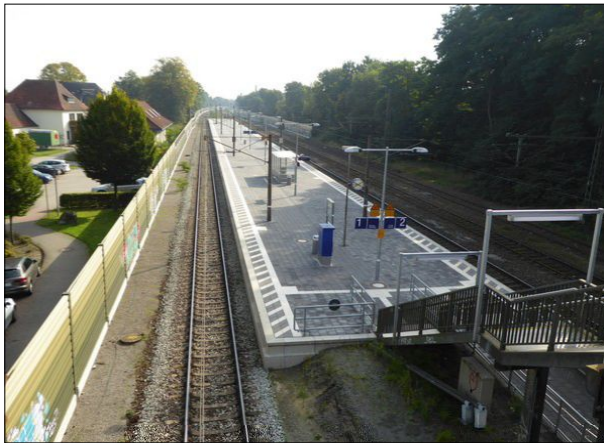
Abb. 5: Bahnsteig und Wetterschutz in Bookholzberg wurden erneuert. Für die stufenfreie Erreichbarkeit des Bahnsteigs sorgt der schon zuvor existierende Aufzug, der jedoch in die Jahre gekommen und störungsanfällig ist.
