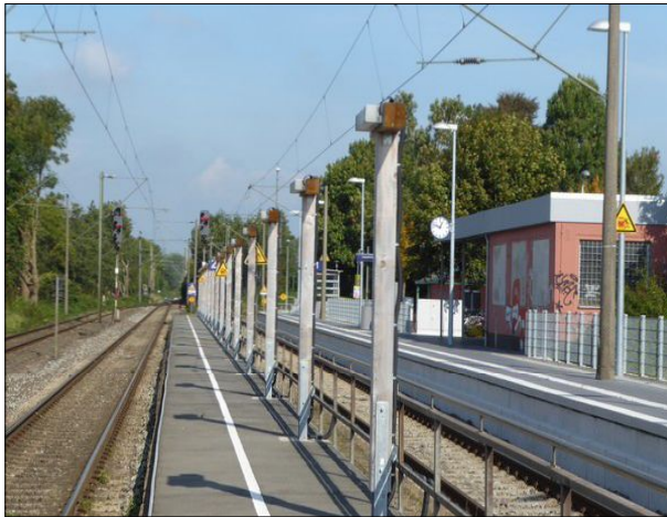
Abb. 47: Der Zwischenbahnsteig in Berne erhielt eine provisorische Bahnsteigbeleuchtung.
