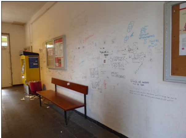
Abb. 35: Mit der Sanierung der Fassade des Empfangsgebäudes von Sottrum wurde begonnen. Im Warteraum wirkte sich das bisher lediglich durch eine neue Eingangstür aus.
