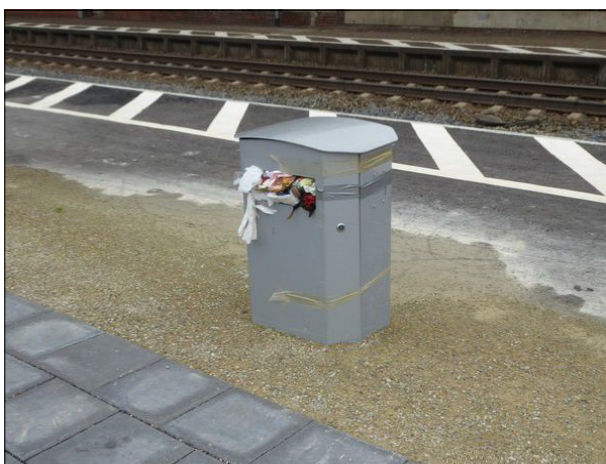
Abb. 21: Bei der Erneuerung des Mittelbahnsteigs in Diepholz wurden die Abfallbehälter einbetoniert. Eine Leerung ist nur noch mit der Zerstörung der Behälter möglich.
