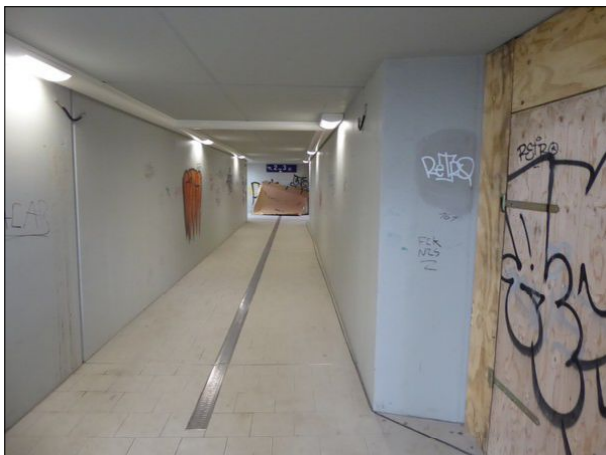
Abb. 41: Die Unterführung zum Mittelbahnsteig in Rastede wurde erneuert. Sie war allerdings bereits wieder umfangreich beschmiert. Die Aufzüge waren noch nicht in Betrieb.
