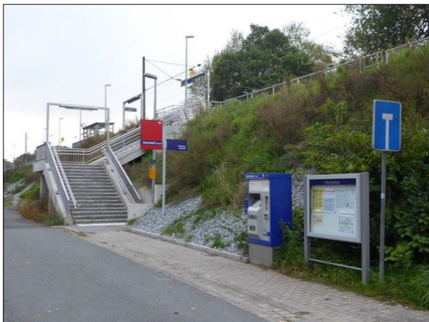
Abb. 6: In Bramstedt wurden die beiden auf einem Damm gelegenen Bahnsteige erneuert und erhöht. Die Zugänge zu den Bahnsteigen wurden jedoch nicht barrierefrei gestaltet. Auf den Bau von Rampen oder Aufzügen wurde verzichtet.
