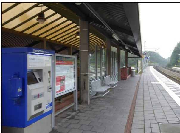
Abb. 2: Die Erneuerung der Bahnsteige in Ritterhude wurde bereits im Jahr 2015 abgeschlossen. Auch der Wartebereich an Gleis 1 wurde dabei modernisiert.
