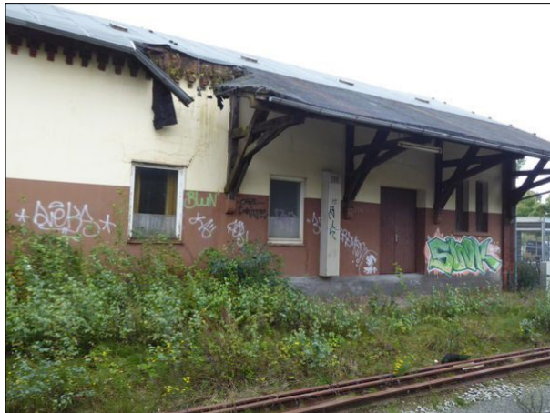
Abb. 50: Der Zustand des ehemaligen Güterschuppens in Osterholz-Scharmbeck beeinträchtigt das Erscheinungsbild des Bahnhofs.
