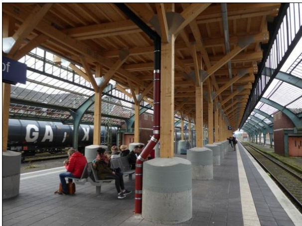
Abbildung 14: In Oldenburg Hbf wurden auf den Mittelbahnsteigen provisorische Überdachungen mit massiven Betonfundamenten gebaut.
