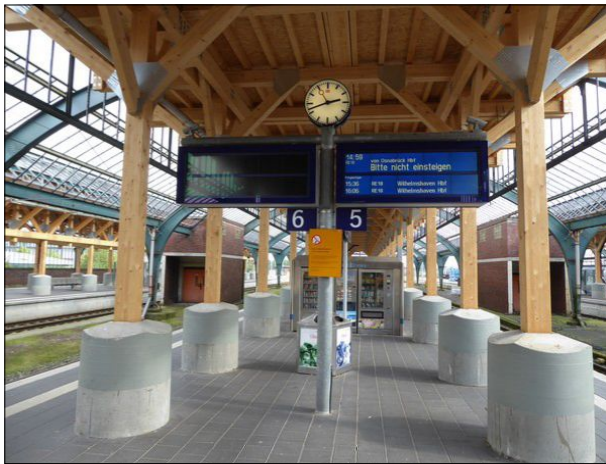
Abb. 22: Der Zugzielanzeiger an Gleis 6 des Oldenburger Hauptbahnhofs war defekt.
