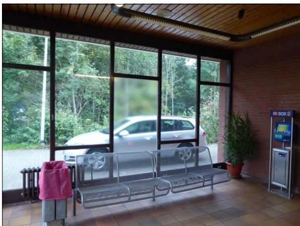
Abb. 54: Der Warteraum im Bahnhofsgebäude von Lemförde wurde durch Instandsetzungen und Reinigung aufgewertet.
