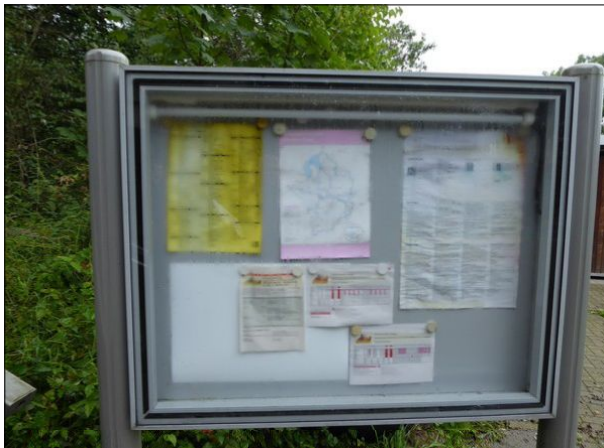
Abb. 31: Die Vitrine am Zugang zu Gleis 1 in Dreye war innen so nass, dass die Scheibe beschlagen war. Die Aushänge schimmelten, und der Fahrplan war nicht lesbar. Zudem fehlte die Abdeckung der Leuchtstoffröhre.
