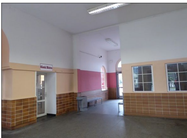
Abb. 36: Obwohl der Kiosk im Empfangsgebäude von Twistringen nicht mehr betrieben wird, steht der Wartebereich weiterhin in gutem Zustand zur Verfügung.
