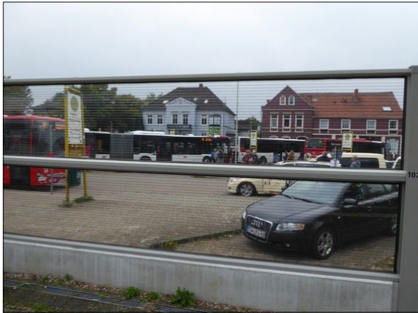
Abb. 49: Die Lärmschutzwand in Verden an Gleis 1 wurde in großen Bereichen transparent gestaltet. Dadurch wird die Aufenthaltsqualität nicht so stark eingeschränkt, wie an anderen Stationen mit Schallschutzwänden.
