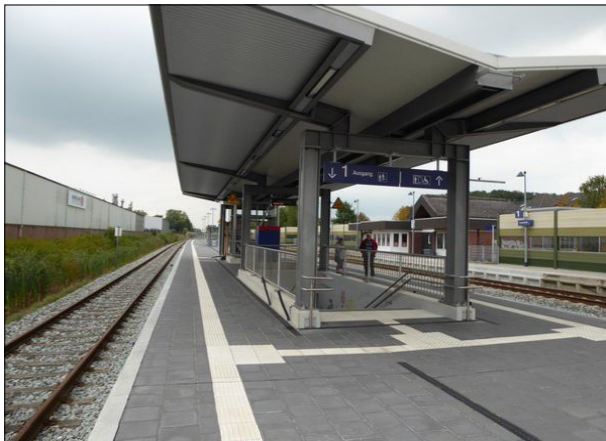
Abbildung 13: Das neue Bahnsteigdach in Rastede reicht auf dem Mittelbahnsteig von der Treppe bis über den Zugang zum Aufzug. Die Aufzüge waren im Herbst jedoch noch nicht fertiggestellt.
