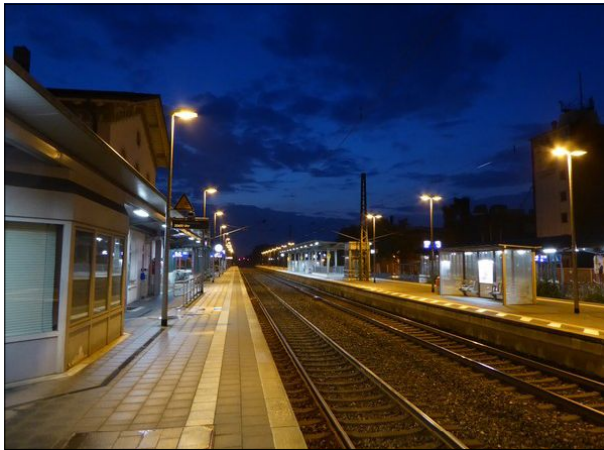
Abb. 46: Die Bahnsteigbeleuchtung in Achim funktionierte einwandfrei.
