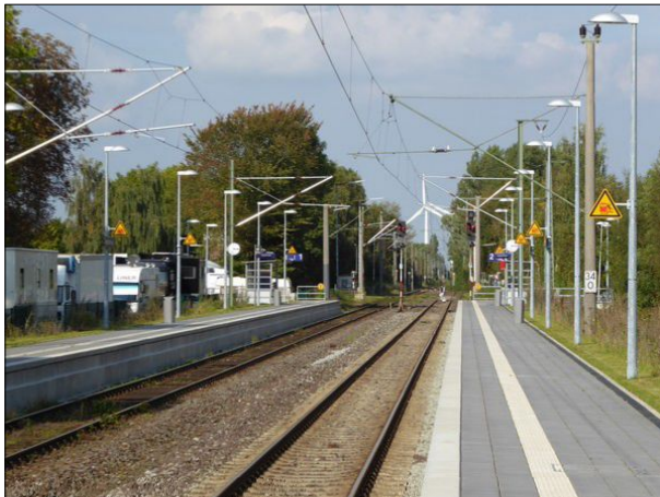
Abb. 4: Im Bahnhof Rodenkirchen wurden neue Bahnsteige in der Nähe zum Bahnübergang angelegt. Von diesem aus sind beide Bahnsteige barrierefrei erreichbar, und die bau-fällige Unterführung konnte geschlossen werden.
