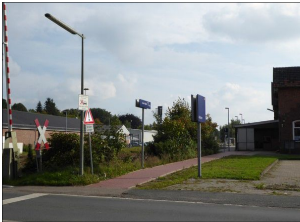
Abb. 40: Der Weg vom Bahnübergang zu Gleis 1 in Ahlhorn wurde erneuert und ist nun durchgehend gepflastert.
