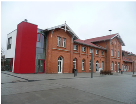
Abb. A-2: saniertes Empfangsgebäude Bf Kirchweyhe
