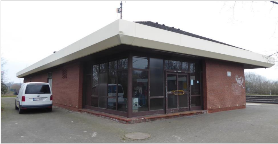
Abb. A-11: Der Flecken Lemförde hat das Bahnhofsgebäude erworben. Damit kann sichergestellt werden, dass der Warteraum auch nach der anstehenden Modernisierung der Verkehrsstation noch zur Verfügung steht. (Quelle: ZVBN)
