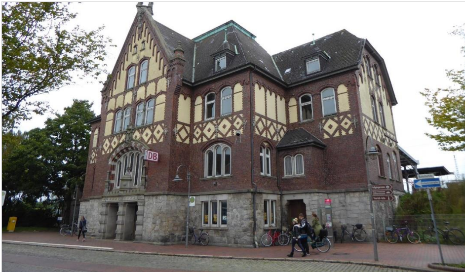
Abb. A-12: Die Verkehrsstation in Brake (Unterweser) wurde zwar modernisiert, das Empfangsgebäude ist jedoch seit Jahren verschlossen und weitgehend ungenutzt. (Quelle: ZVBN)
