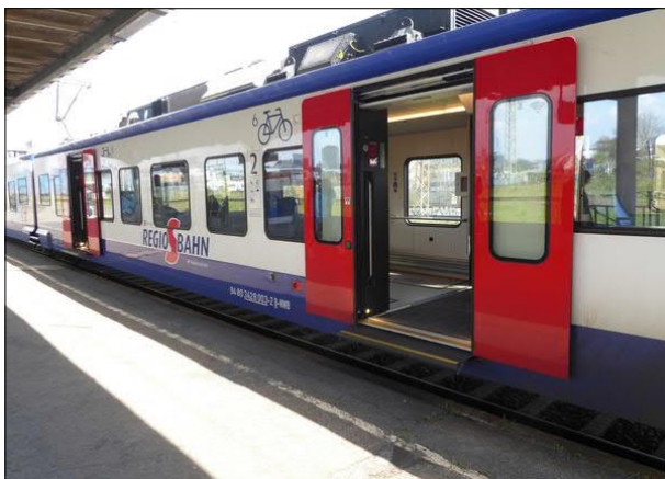
Abbildung 6: In Bremen-Neustadt muss neben dem Bau eines Aufzugs zur barrierefreien Erreichbarkeit des Bahnsteigs auch der Bahnsteig auf das Fußbodenniveau der Züge erhöht werden.
