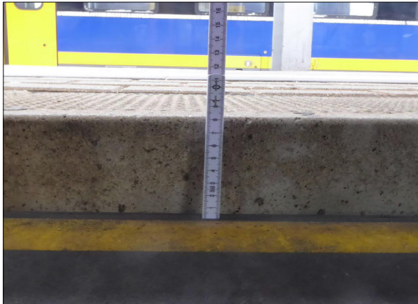
Abbildung 4: Ganz stufenlos geht es selten vom Zug auf den Bahnsteig. Eine Stufenhöhe von 8 cm, wie hier beim Halt einer Regio-S-Bahn in Bremen-Vegesack, ist ein Extremfall. Das Aussteigen für Rollstuhlfahrende ist dann jedoch ohne Hilfe kaum möglich.
