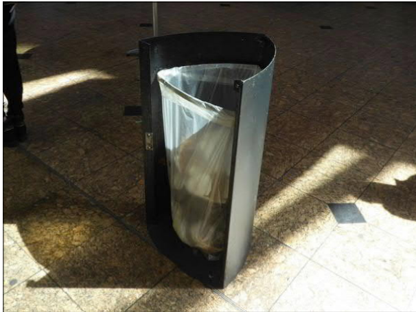
Abbildung 13: An diesem Abfallbehälter in Bremen Hbf im Zugang von der Bürgerweide fehlten die Abdeckung und eine Tür.
