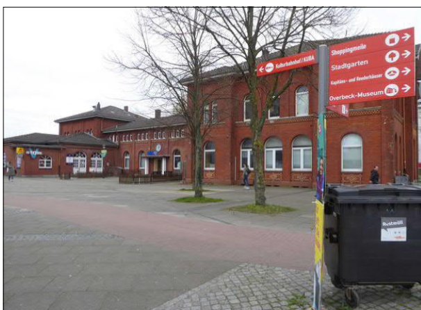
Abbildung 24: Die Wegeleitungsschilder auf dem Bahnhofsvorplatz in Bremen-Vegesack weisen teilweise in falsche Richtungen.
