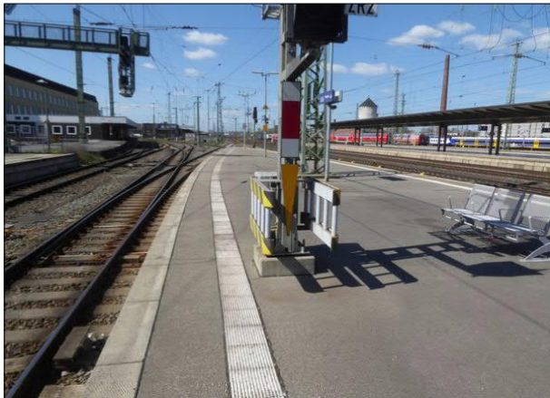
Abbildung 5: Der Abstand zwischen dem Leitstreifen und diesem Signal in Bremen Hbf an Gleis 2 ist mit weniger als 15 cm viel zu klein. Das Blindenleitsystem muss in dem Bereich um das Signal herum geführt werden.
