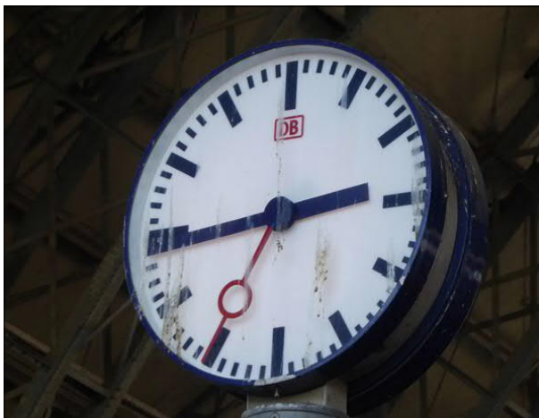
Abbildung 20: In Bremen Hbf waren einzelne Uhren durch Taubenkot verschmutzt.
