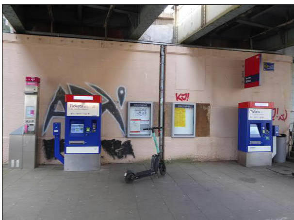
Abbildung 27: Die Vitrinen im Zugangsbereich von Bremen-Walle wurden erneuert. Die neuen Vitrinen sind allerdings nur halb so groß wie die alten. Außerdem wurde ein zweiter Fahrkartenautomat installiert.
