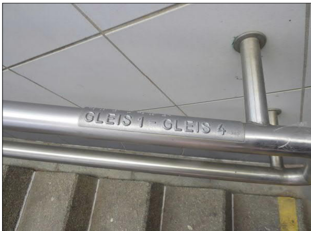
Abbildung 23: Diese Beschriftung auf dem Handlauf der Bahnsteigtreppe in Bremerhaven-Lehe ist falsch. An dem Mittelbahnsteig liegen die Gleise 3 und 4.
