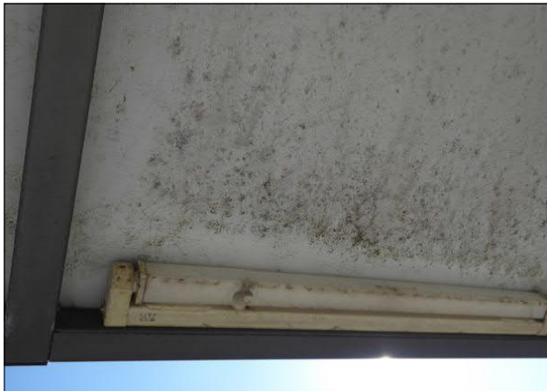
Abbildung 49: Die Decke und die Leuchten des Unterstands in Bremerhaven-Lehe waren verschmutzt. Die Lampenhauben waren auch beschädigt, und in einer Leuchte fehlte das Leuchtmittel.
