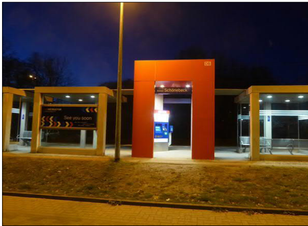
Abbildung 10: Die roten Elemente der sogenannten Plus-Punkte in Bremen-Schönebeck wurden neu gestrichen. Das wirkt sich sehr positiv auf das Erscheinungsbild aus.
