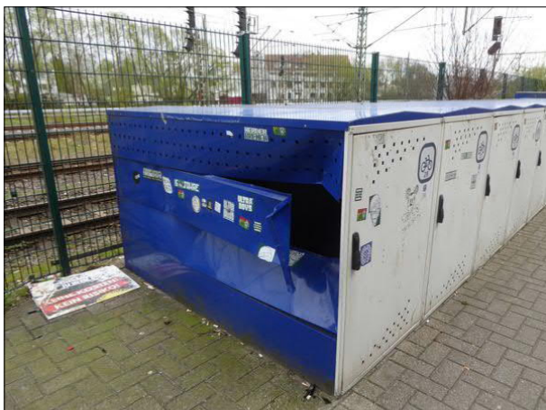
Abbildung 41: In Bremen-Burg wiesen die Fahrradboxen im Zugangsbereich Beschädigungen und Verschmutzungen auf.
