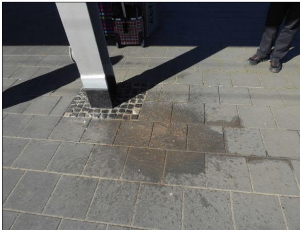
Abbildung 7: In Bremerhaven Hbf waren die Bahnsteige stellenweise verschmutzt.
