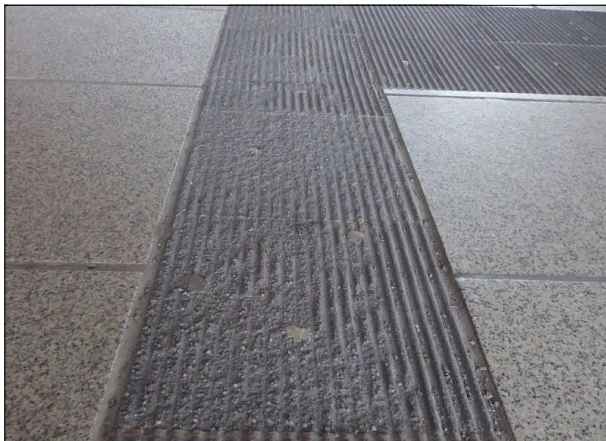
Abbildung 8: Die Platten der Blindenleitstreifen an den Gleisen 5/6 in Bremen Hbf sind im zentralen Bahnsteigbereich schon seit mehreren Jahren abgenutzt.
